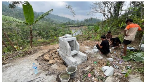
Gambar 12. Proses Pembuatan Rocket Stove
