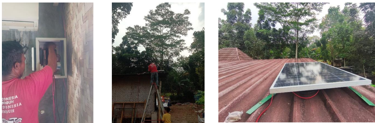
Gambar 9. instalasi dan uji fungsi solar system untuk beban budidaya
