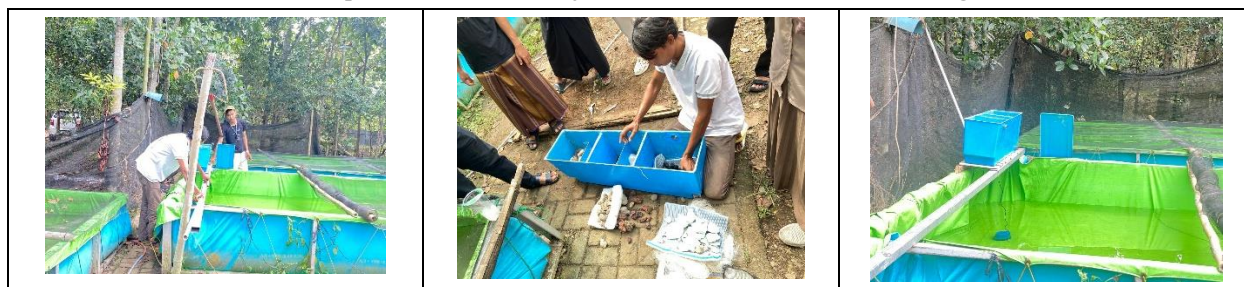
Gambar 8. instalasi dan uji fungsi sistem RAS pada kolam terpal
