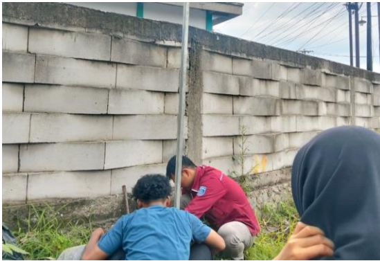
Gambar 5 Pengecoran Plang Petunjuk Arah
