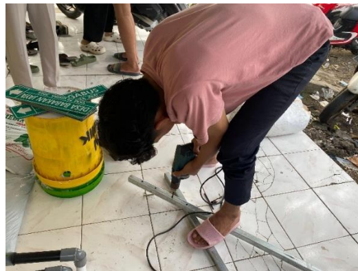
Gambar 2 Melubangi Tiang Hollow Galvanis
