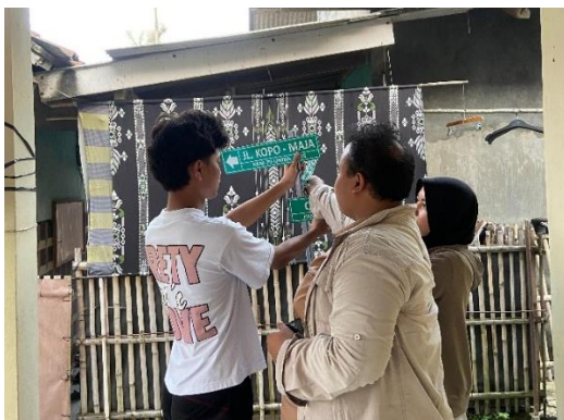
Gambar 3 Pemasangan Plat pada Tiang
